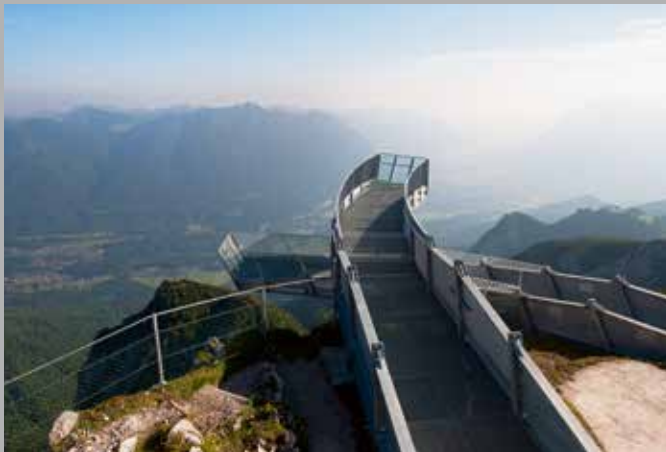
Aussichtsplattform mit verzinkten Pressrosten
